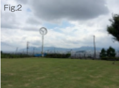
風レンズ応用風力発電機 (日本平動物園) 株式会社風レンズ(福岡)
